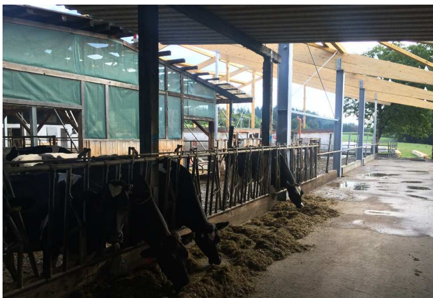
Bilder Bauphase im laufenden Stallbetrieb
